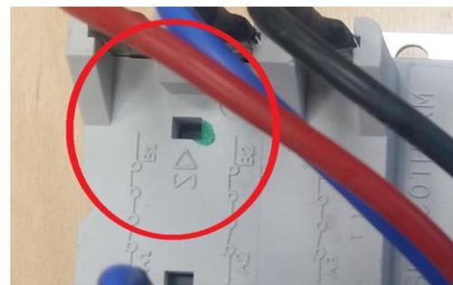
**Pour les PAC avec production d'eau chaude ( modèle DUO) il existe aussi un réarmement sur la résistance ECS**
